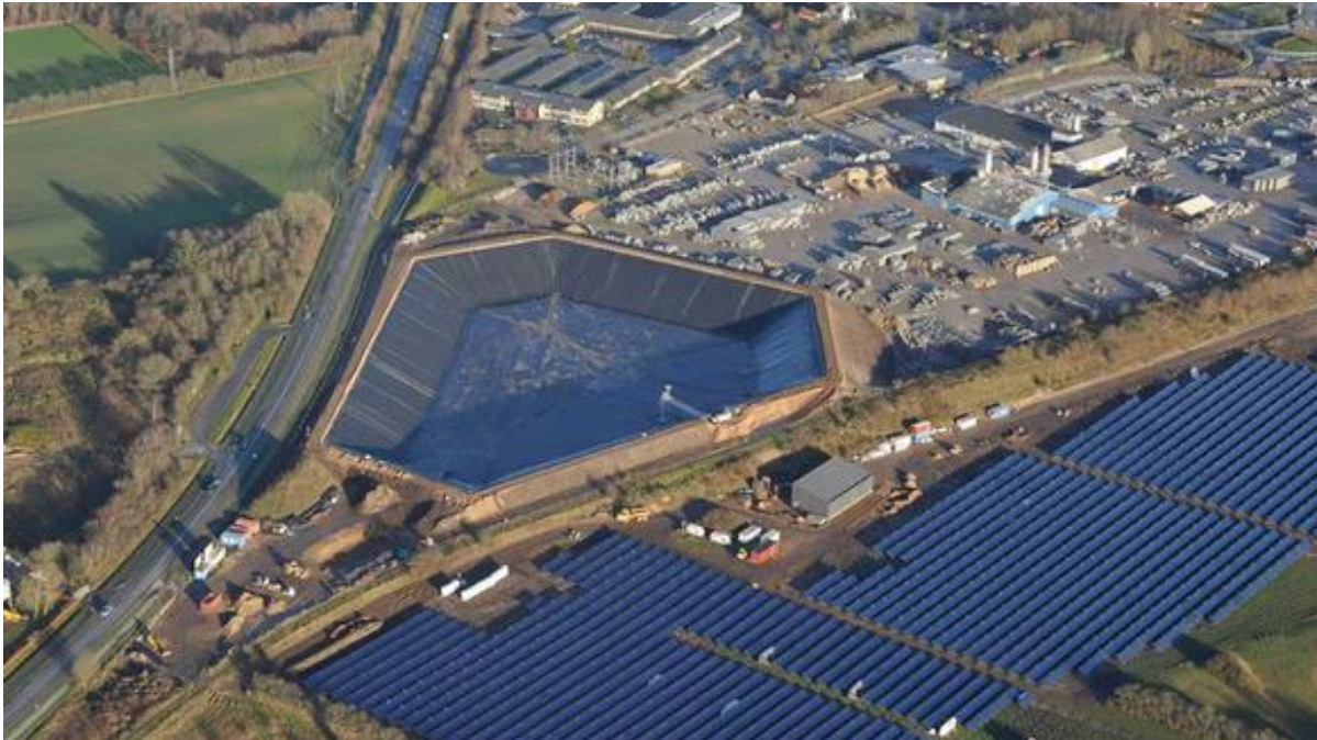
Abbildung 18: Erdwärmespeicher im dänischen Vojsens 8
