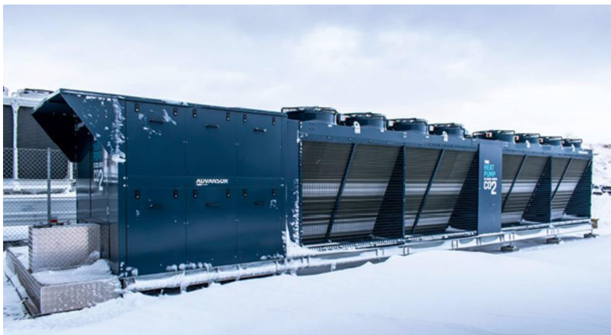
Abbildung 12: CO 2 Großwärmepumpe des Herstellers Advansor
